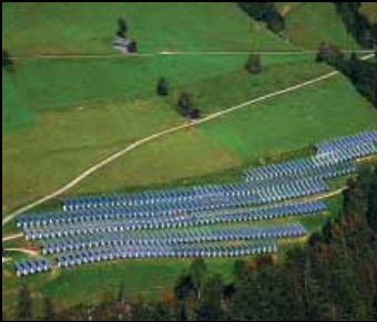
Petite installation de production d'énergie
